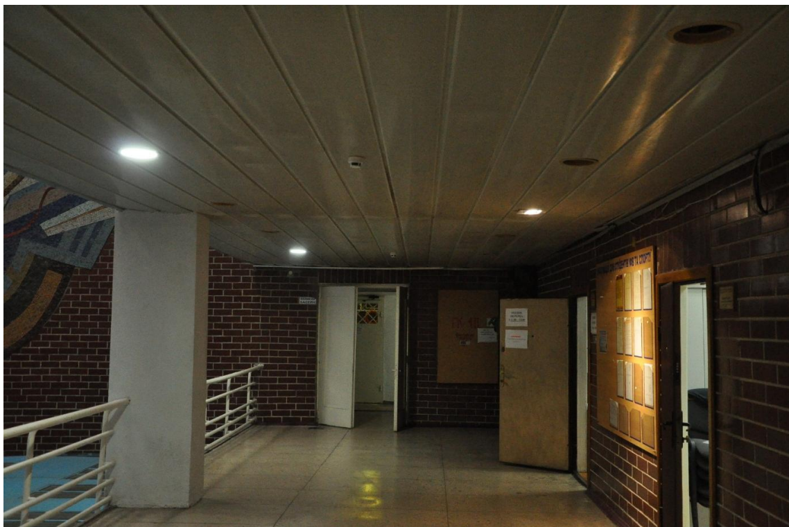
Замінено освітлення в холі 2-го поверху на економне LED-освітлення.
