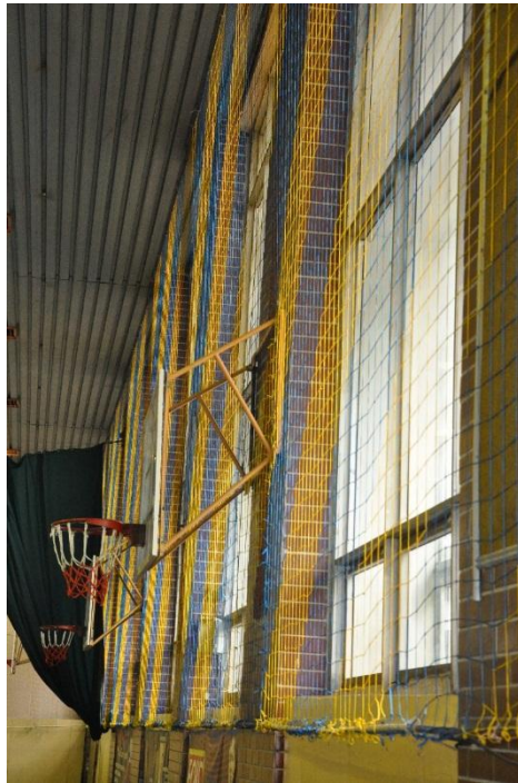
Замінена сітка огорожувальна на вікнах
